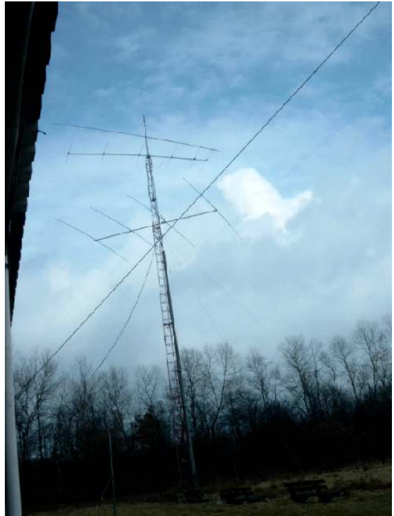
De NOK mast
