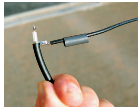
Fig. 4. Het voorbereiden van de coaxuiteinden.
