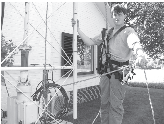
Fig. 9 Eén einde van de 10,5 mm koord is bevestigd aan het klimpak. Het terugkerende einde passeert het remmechanisme (zie ook fig. 10). Over de totale lengte tussen het klimpak en het remmechanisme dient de lijn te allen tijde onder spanning te staan.
