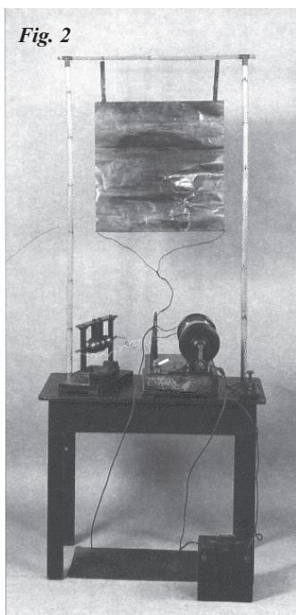
bereik van de radiogolven groter wordt naarmate hij een lagere frequentie gebruikt. Dit is het begin van de radiocommunicatie op langegolf, die enkele tientallen jaren lang het hele radiogebeuren zal domineren. De overbrugbare afstand wordt voornamelijk bepaald door het zendvermogen en de afmetingen van de zendantenne.
